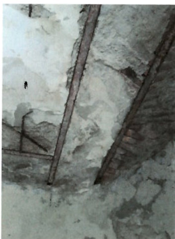
Foto5. Profile metalice planșeu corodate Foto6. Fisuri în pereții de compartimentare
