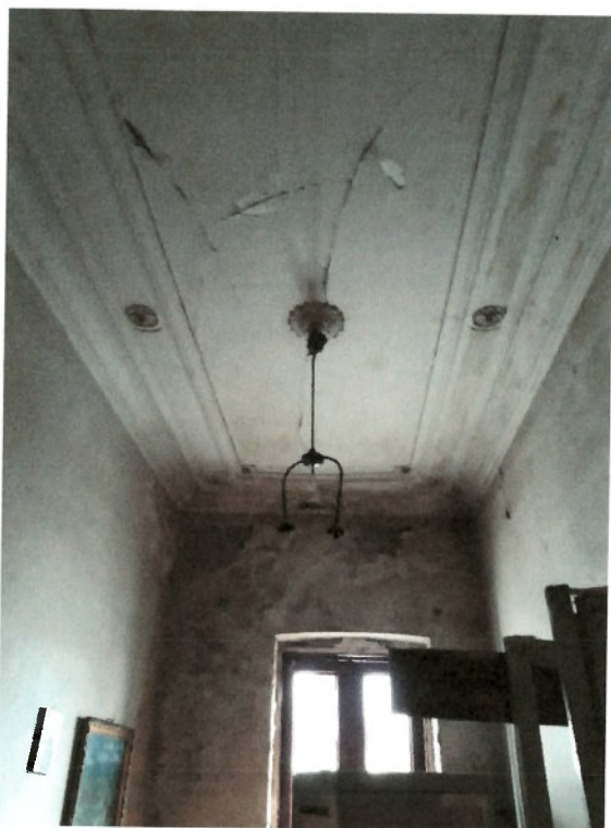
Foto8. Infiltrații puternice în pereții exteriori
