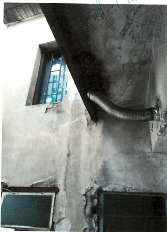
Foto9. Degradării ale tencuielilor curții de lumina
